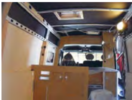
Sonderausbau Renault Master im Bau
